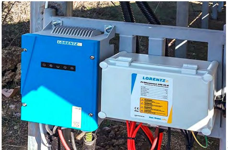
Der Controller steuert das Fördervolumen und schaltet die Pumpen ein und aus.
