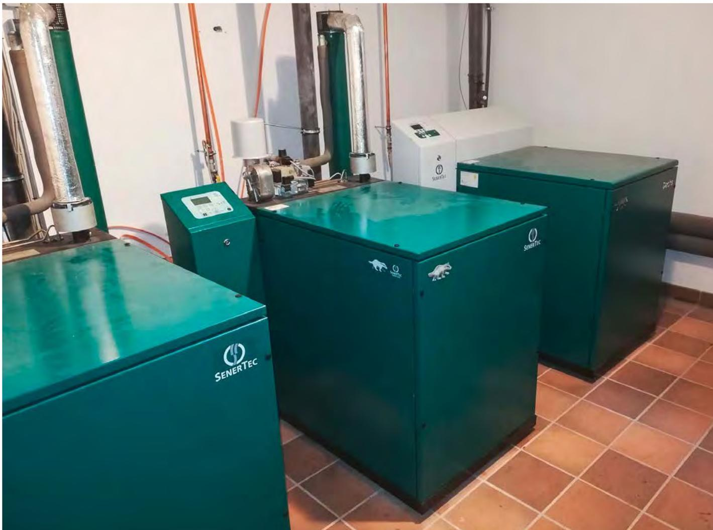
Drei BHKW vom Typ Dachs der Firma Senertec laufen im Heizungskeller.
