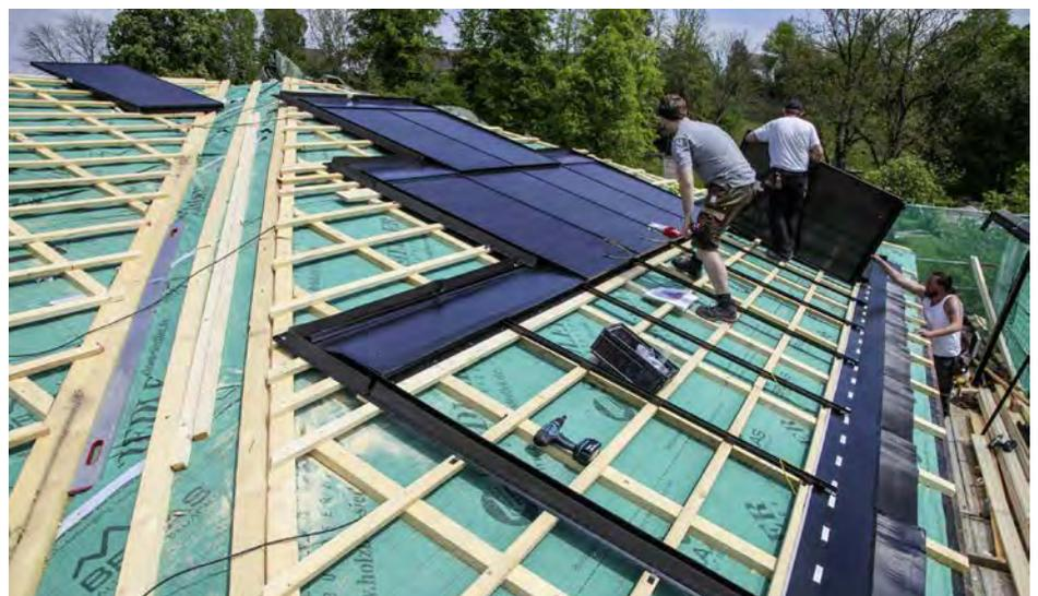
Die Verlegung der Module erfolgt von links nach rechts und von oben nach unten.
