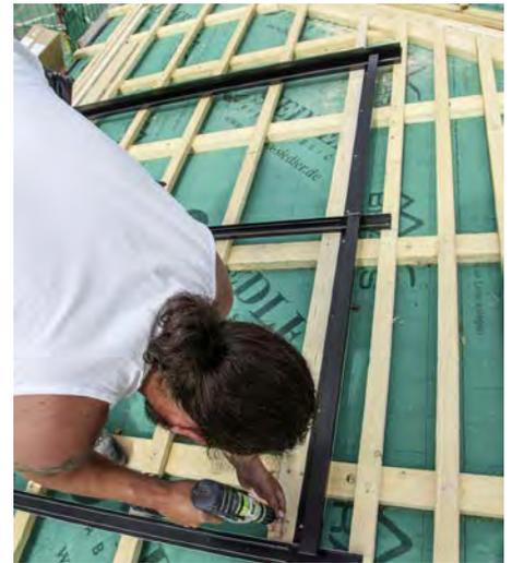
Der universelle Eindeckrahmen besteht aus einem Grundset für zwei mal zwei Module und wird durch Erweiterungssets in horizontaler und vertikaler Richtung erweitert.
