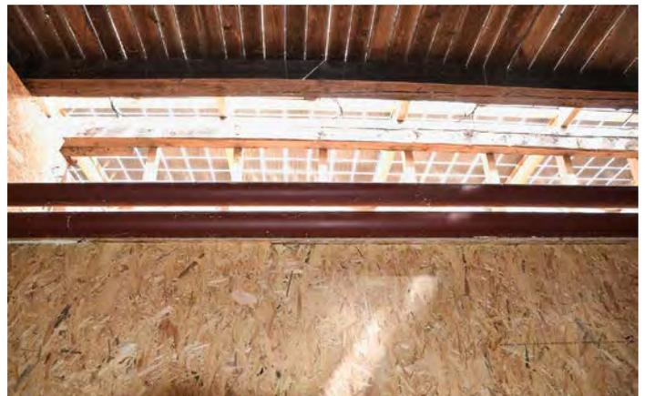
Die semitransparenten Module erhöhen den Wärmeeintrag.
