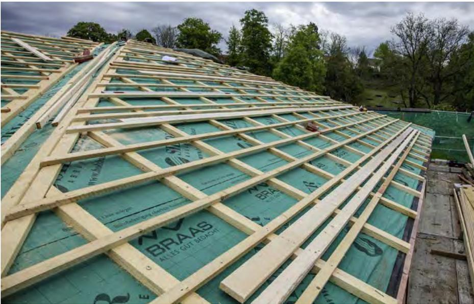
Traufseitig wurde eine Bohle montiert, um die Modulreihen sicher in der Dachlattenebene befestigen zu können.
